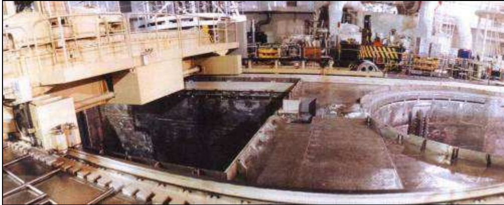
Obr. 4.3 Odkrytý BSVP JE Temelín
