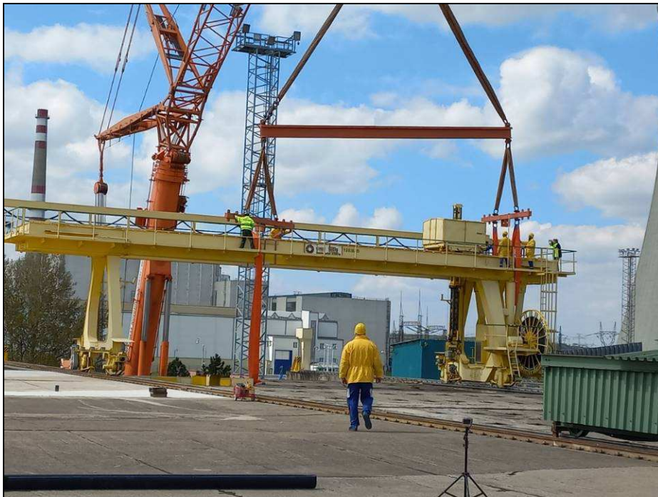
Obr. 8.3 Přesun portálového jeřábu na sousední řadu
