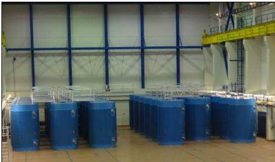
Obr. 4.2 Skladovací hala SVP Dukovany
