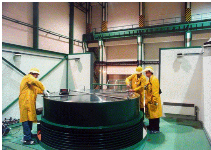
Obr. 7.5 Periodická kontrola tlakového snímače
