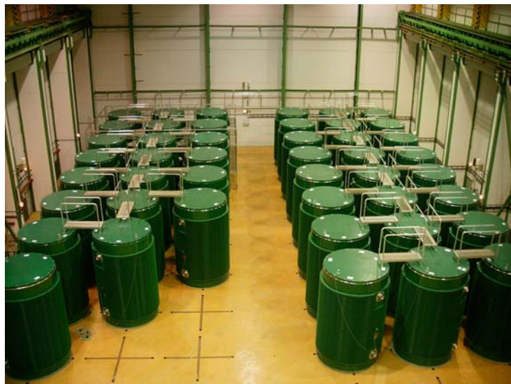
Obr. 7.1 Pohled do skladovací haly MSVP Dukovany s 45 OS CASTOR-440/84
