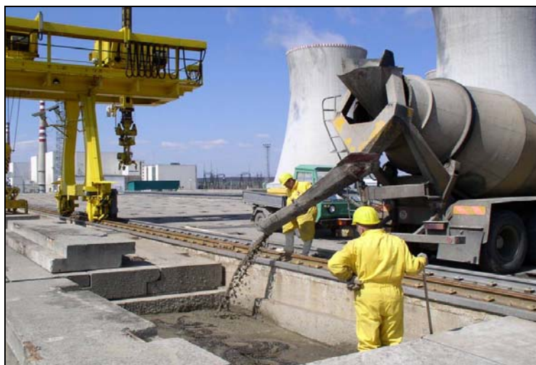
Obr. 8.3 Vyplňování zaplněné jímky betonem
