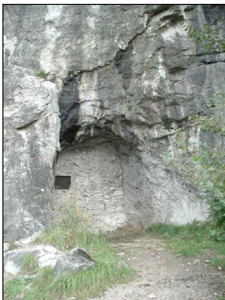
Obr. 8.5 Zabezpečený vchod do úložiště Hostím
