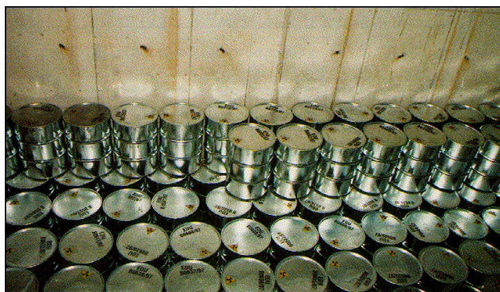
Obr. 8.4 Pohled do částečně zaplněné úložné jímky ÚRAO Dukovany
