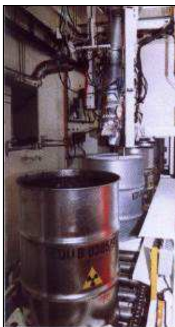
Obr. 4.5 Pohled na bitumenační linku na úpravu KRAO
