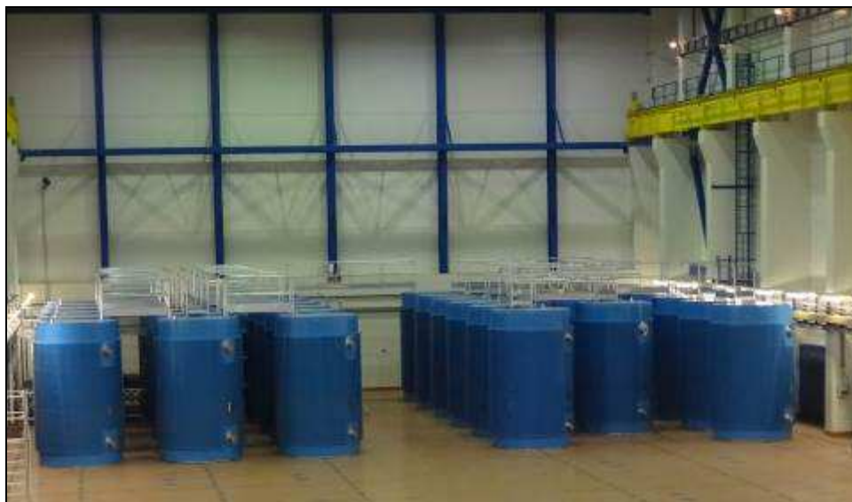
Obr. 4.2 Skladovací hala SVP Dukovany
