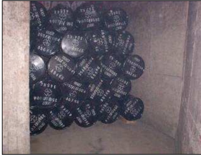
Obr. 8.1 Pohled do úložné komory ÚRAO Richard
