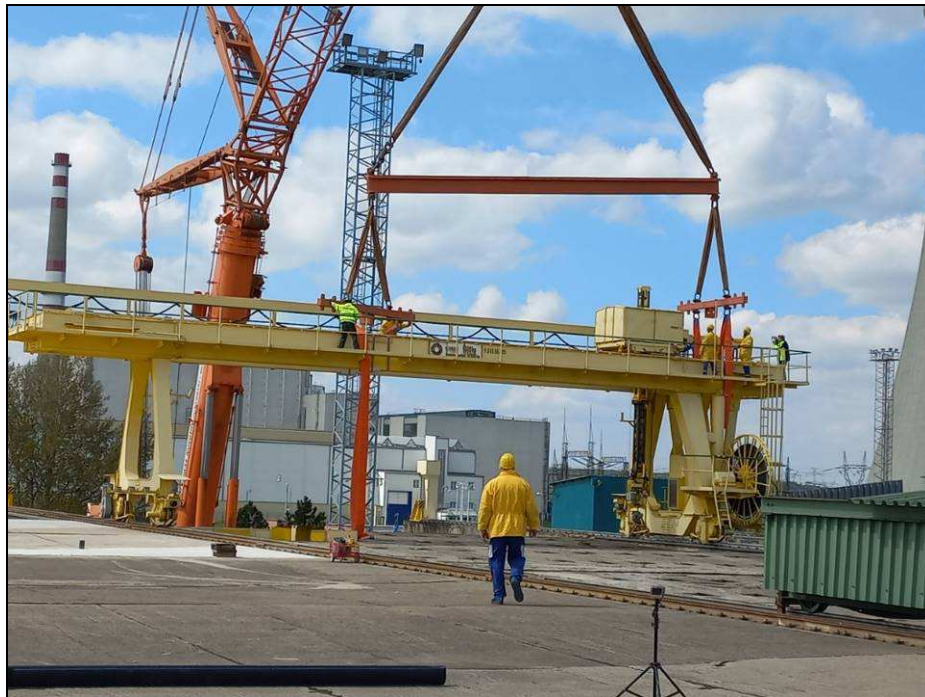
Obr. 8.3 Přesun portálového jeřábu na sousední řadu
