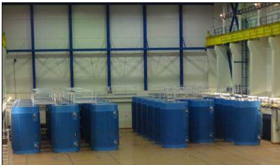
Obr. 4.2 Skladovací hala SVP Dukovany
