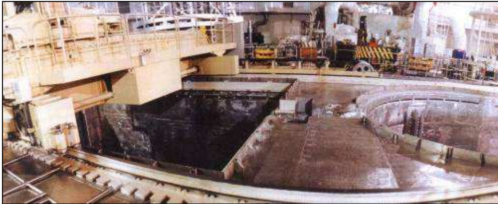
Obr. 4.3 Odkrytý BSVP JE Temelín
