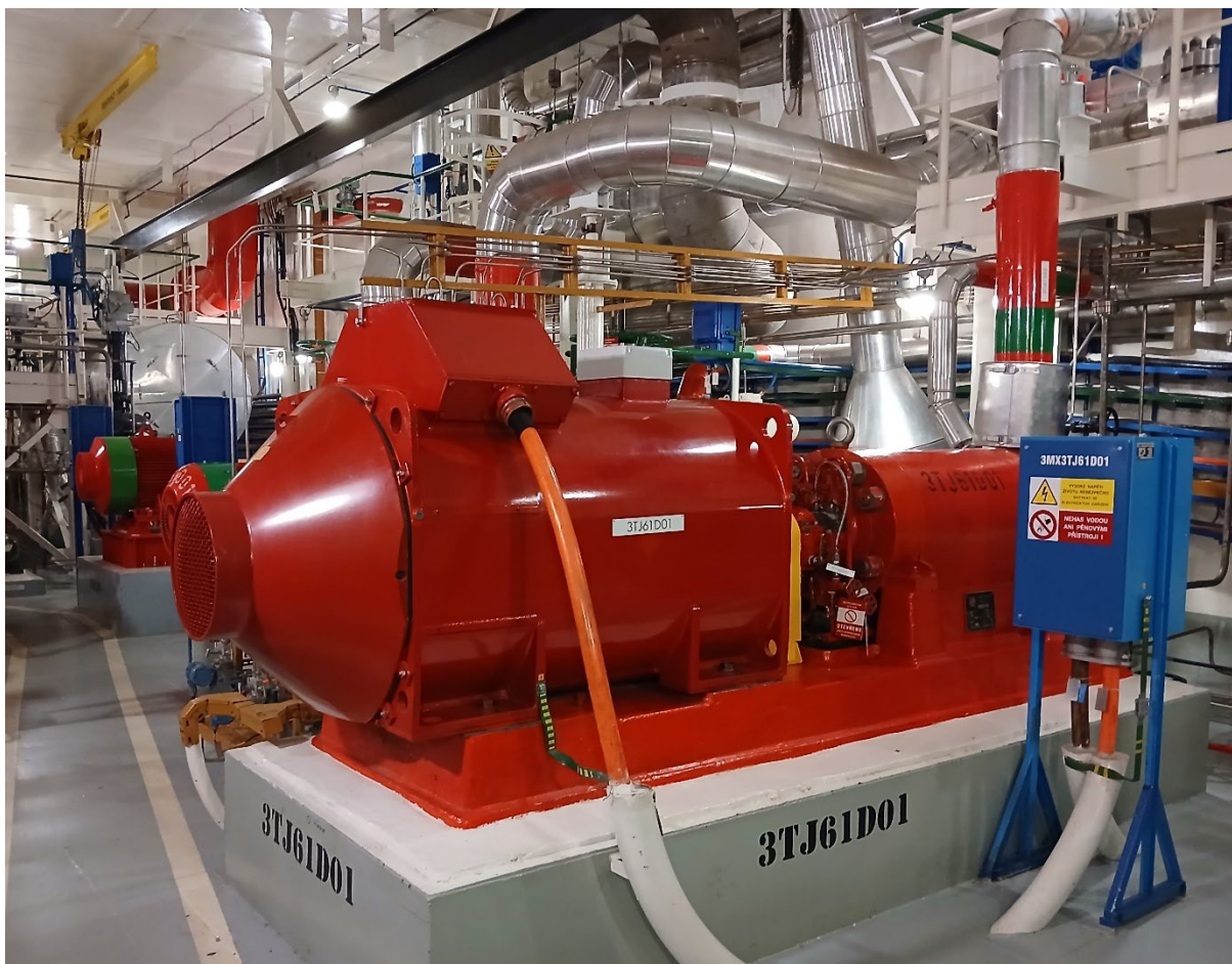
Obrázek č. 4 – Vysokotlaké havarijní čerpadlo SAOZ
